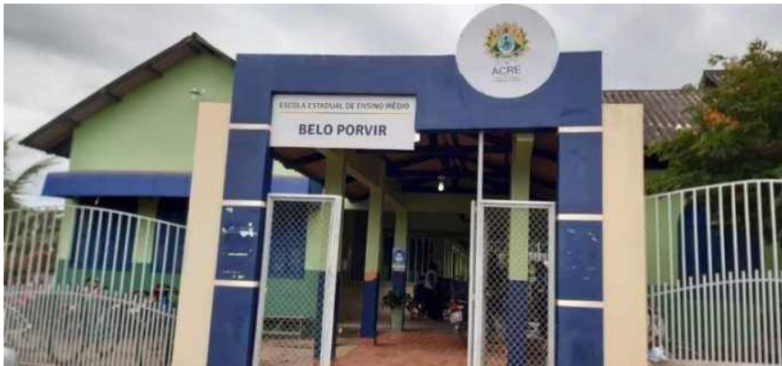
Imagem 01: Escola Belo Porvir entrada central
