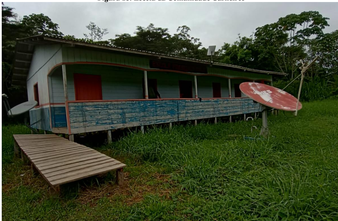
Figura 18: Escola da Comunidade Carneiros
