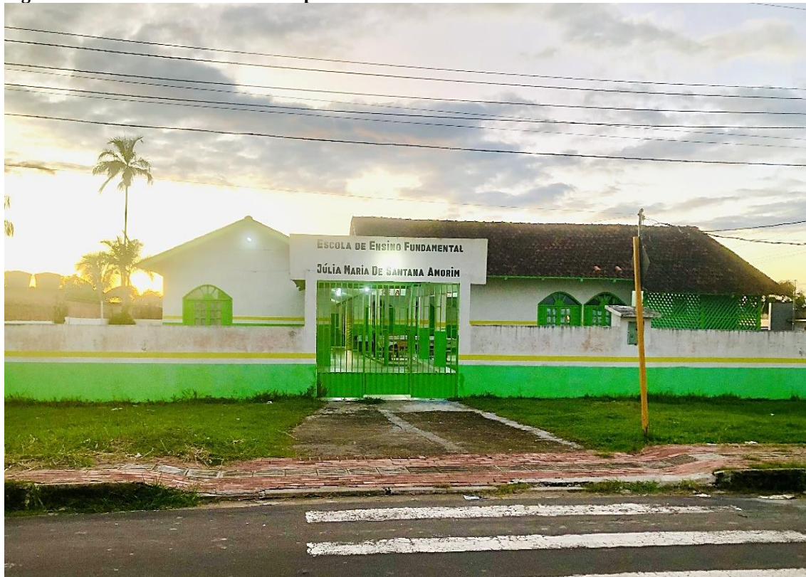
Figura 5 - Fachada da Escola Municipal de Ensino Fundamental I Júlia Maria de Santana Amorim.
