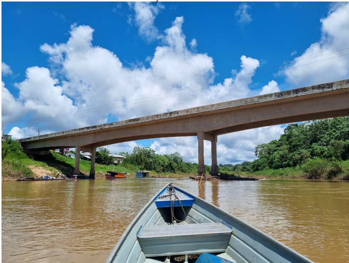
Figura 22 – Ponte sobre o Rio Liberdade, que liga a BR 364, na Comunidade Vila Liberdade. Registro realizado em janeiro de 2024.
