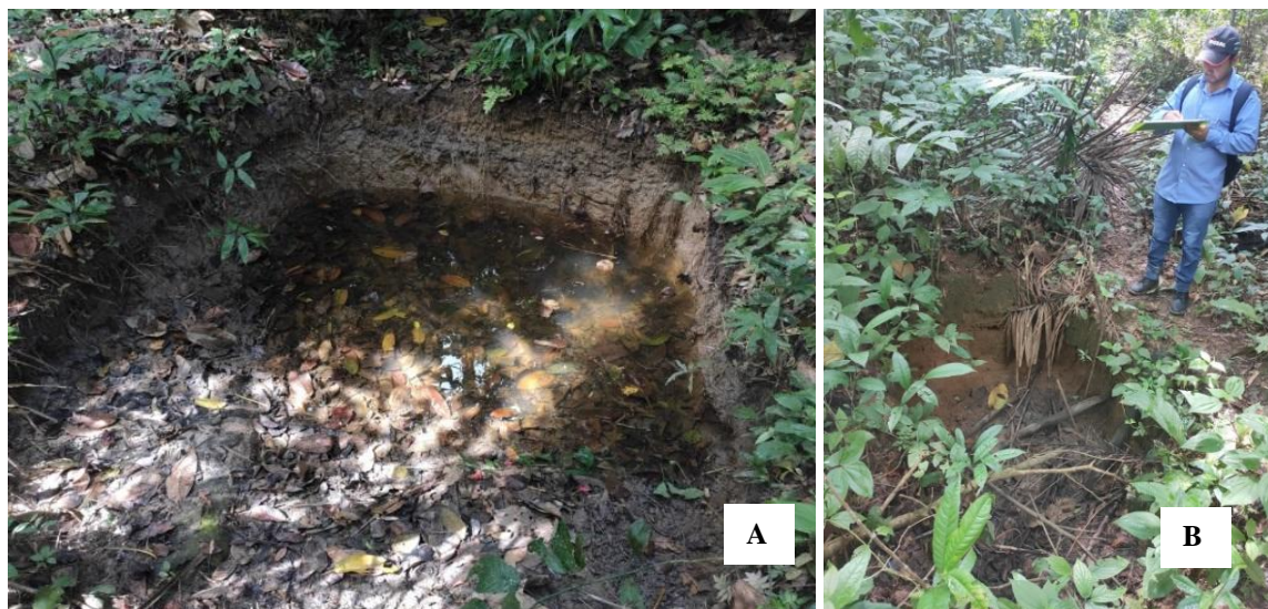
Figura 39 - Trincheiras (A) em uma das trilhas secundárias da Estrada de Seringa e (B) no Experimento Arboreto.
