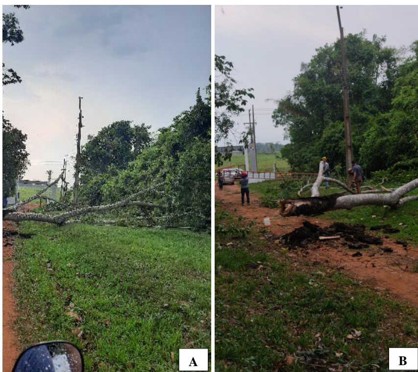
Figura 46 - Danos ocasionados à rede elétrica por queda de galhos. Fotos: (A) Joseane Jácome; (B) André Lobato
