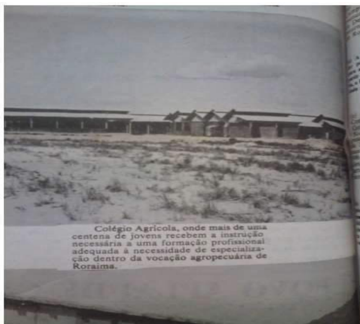
Figura 02- CONSTRUÇÃO DA PRIMEIRA ESCOLA AGROTÉCNICA DE RORAIMA – 1980
