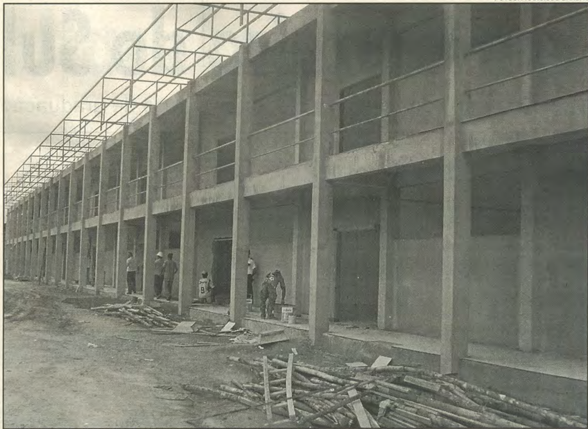
Obras da Ufac no Campus do Canela Fina, em Cruzeiro do Sul, encontram-se em fase de conclusão
