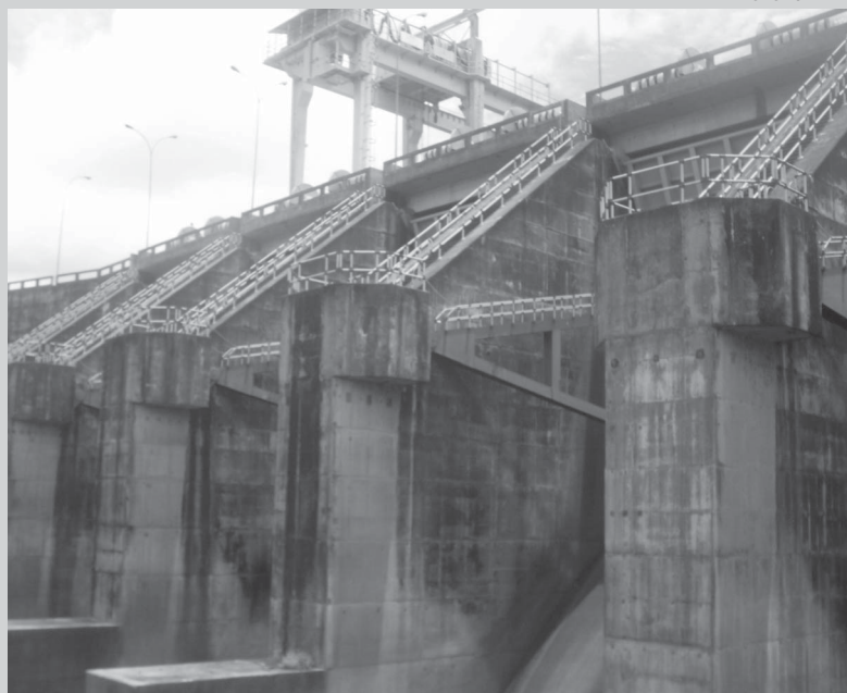
Hidrelétrica de Samuel, em Rondônia
