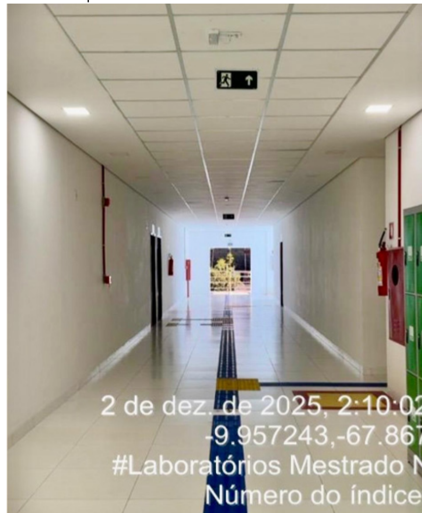
Figura 109 - Corredor do Bloco dos Laboratórios do Mestrado em Saúde - Campus Sede.
