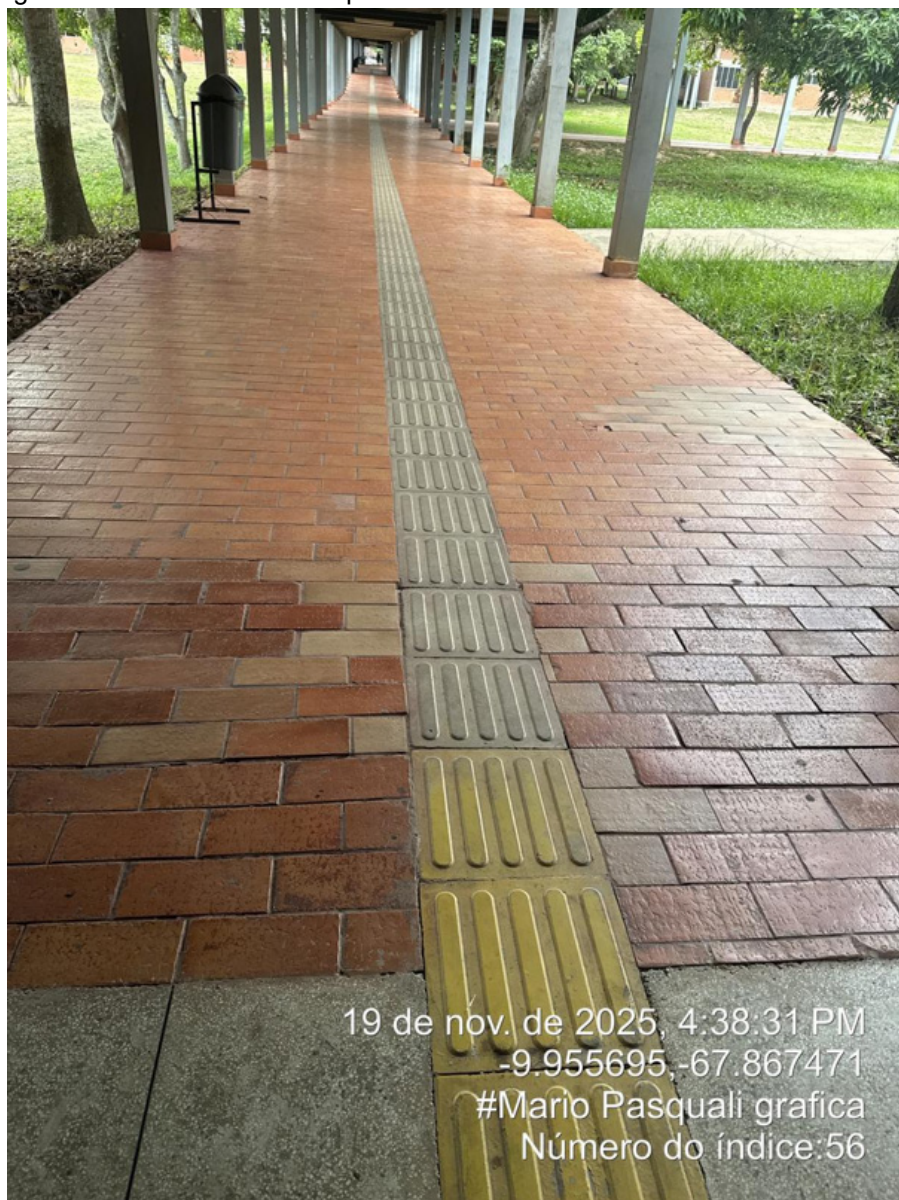
Figura 102 - Bloco D01 - Campus Sede.
