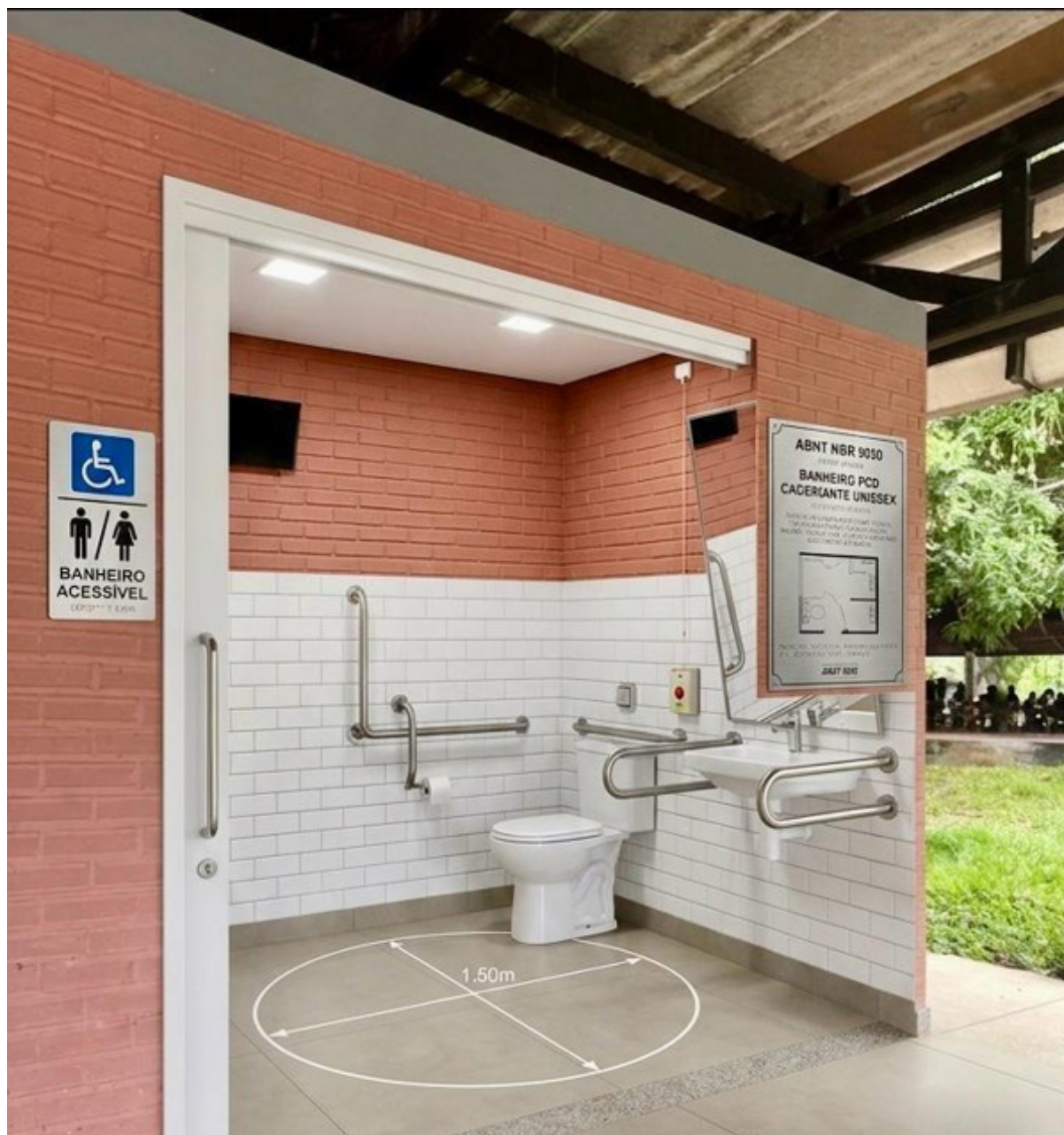
Figura 138 - Ilustração de sanitário acessível em ambiente da Ufac. Em Conformidade com a Norma
