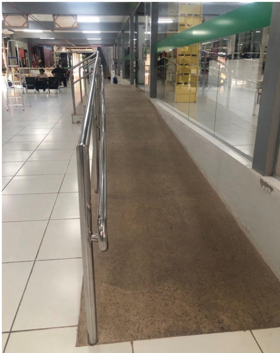
Figura 30 - Rampa interna da Biblioteca Central - Campus Sede.
