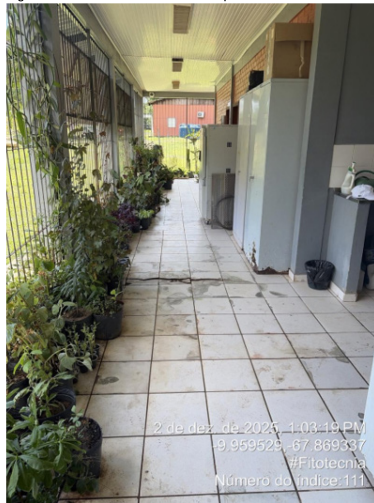
Figura 53 - Bloco de Fitotecnia - Campus Sede.
