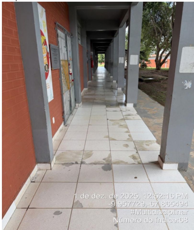
Figura 87 - Corredor de salas de aula do Bloco Multidisciplinar - Campus Sede.
