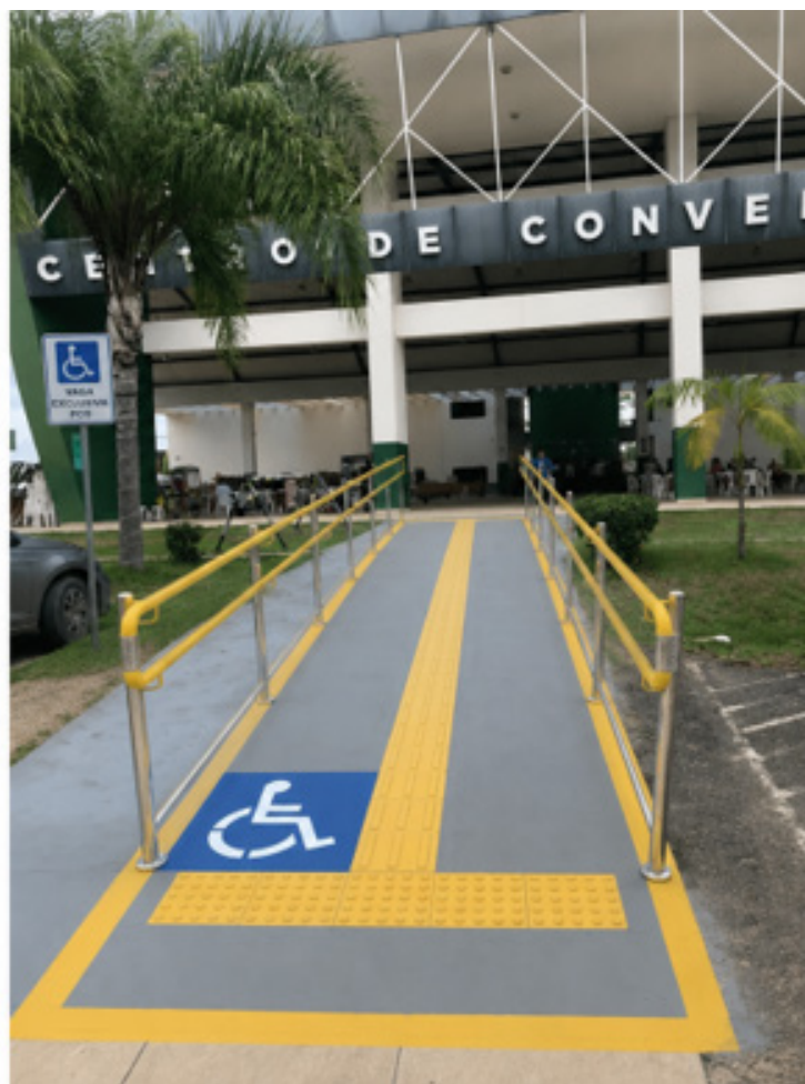
Em Conformidade com a Norma
