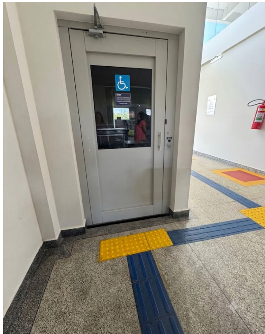
Figura 31 - Elevador Bloco CFCH - Campus Sede.
