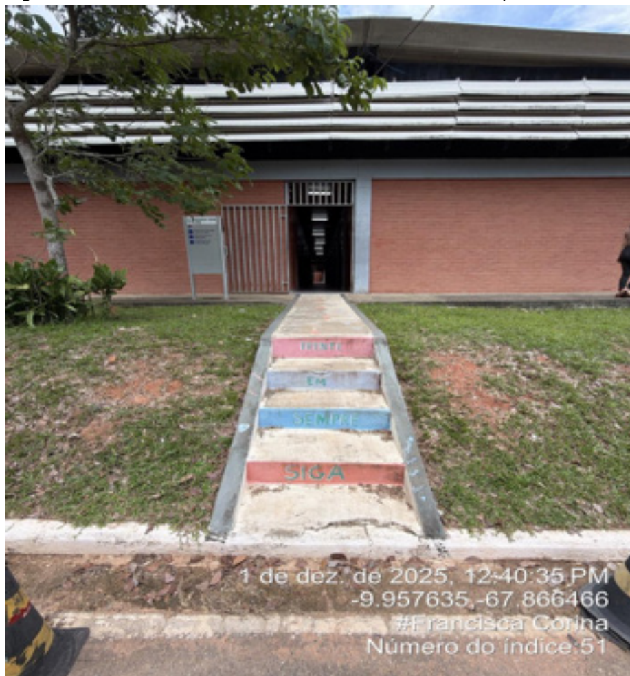
Figura 23 - Escada externa do Bloco Francisca Corina - Campus Sede.
