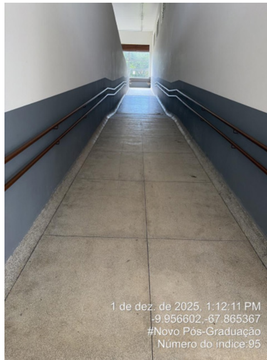
Figura 29 - Rampa interna do Bloco Novo da Pós-Graduação - Campus Sede.
