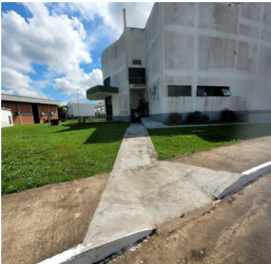
Figura 25 - Rampa externa do Teatro Universitário - Campus Sede.
