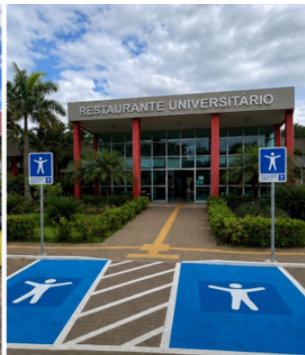
Em Conformidade com a Norma
