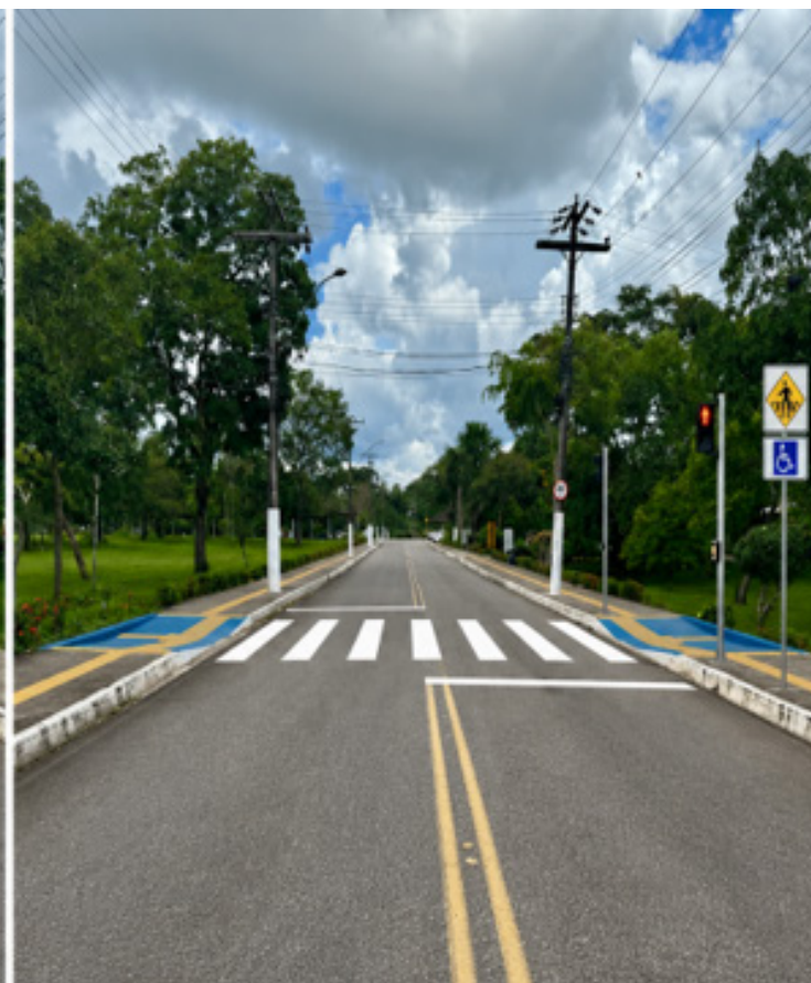
Em Conformidade com a Norma
