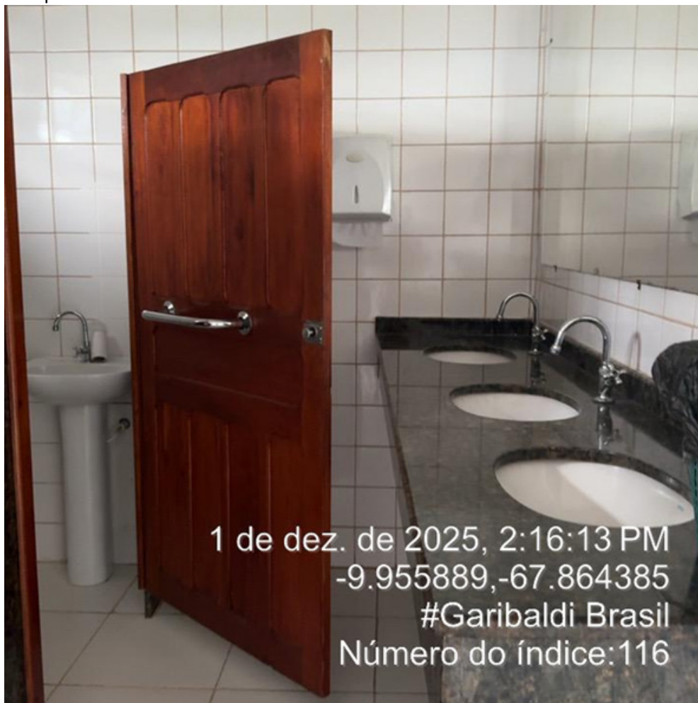
Figura 61 - Sanitário para pessoa com deficiência do Anfiteatro Garibaldi Brasil - Campus Sede.
