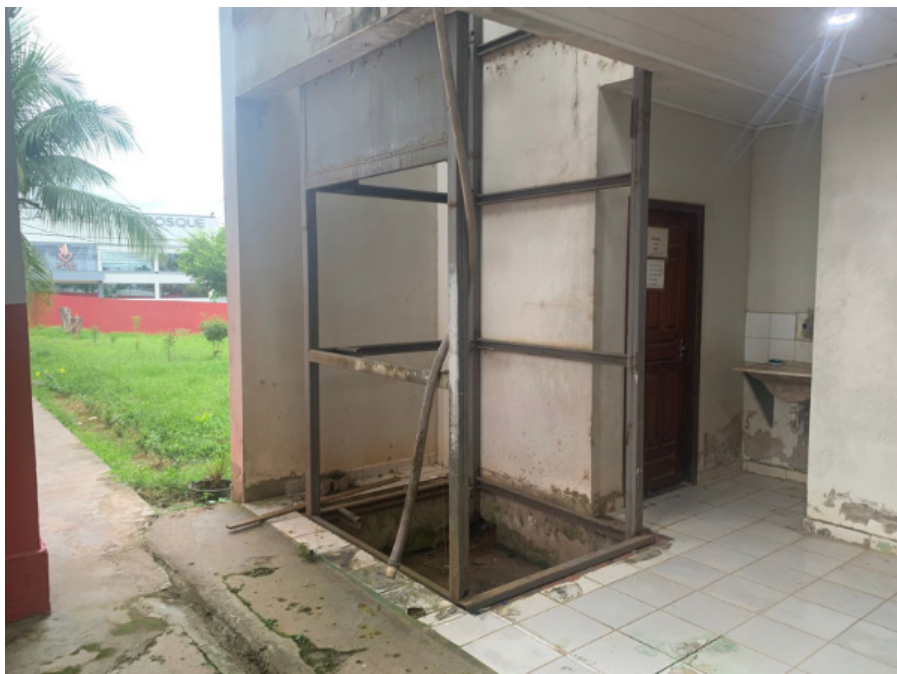
Figura 35 - Estrutura de plataforma elevatória inacabada - Núcleo de Sena Madureira.
