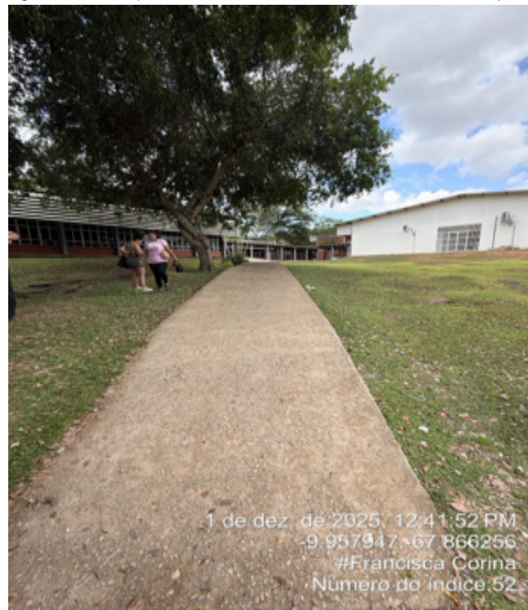
Figura 22 - Rampa externa do Bloco Francisca Corina - Campus Sede.
