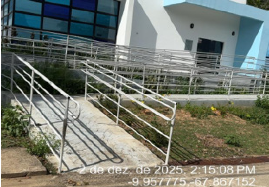
Figura 18 - Rampa de acesso ao Bloco dos Mestrados em Saúde - Campus Sede.
