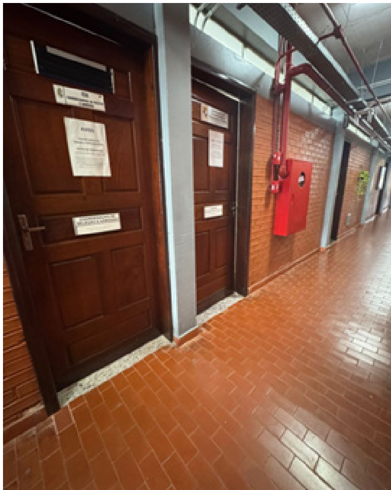
Figura 44 - Corredor do 2º piso do Bloco da Reitoria - Campus Sede.
