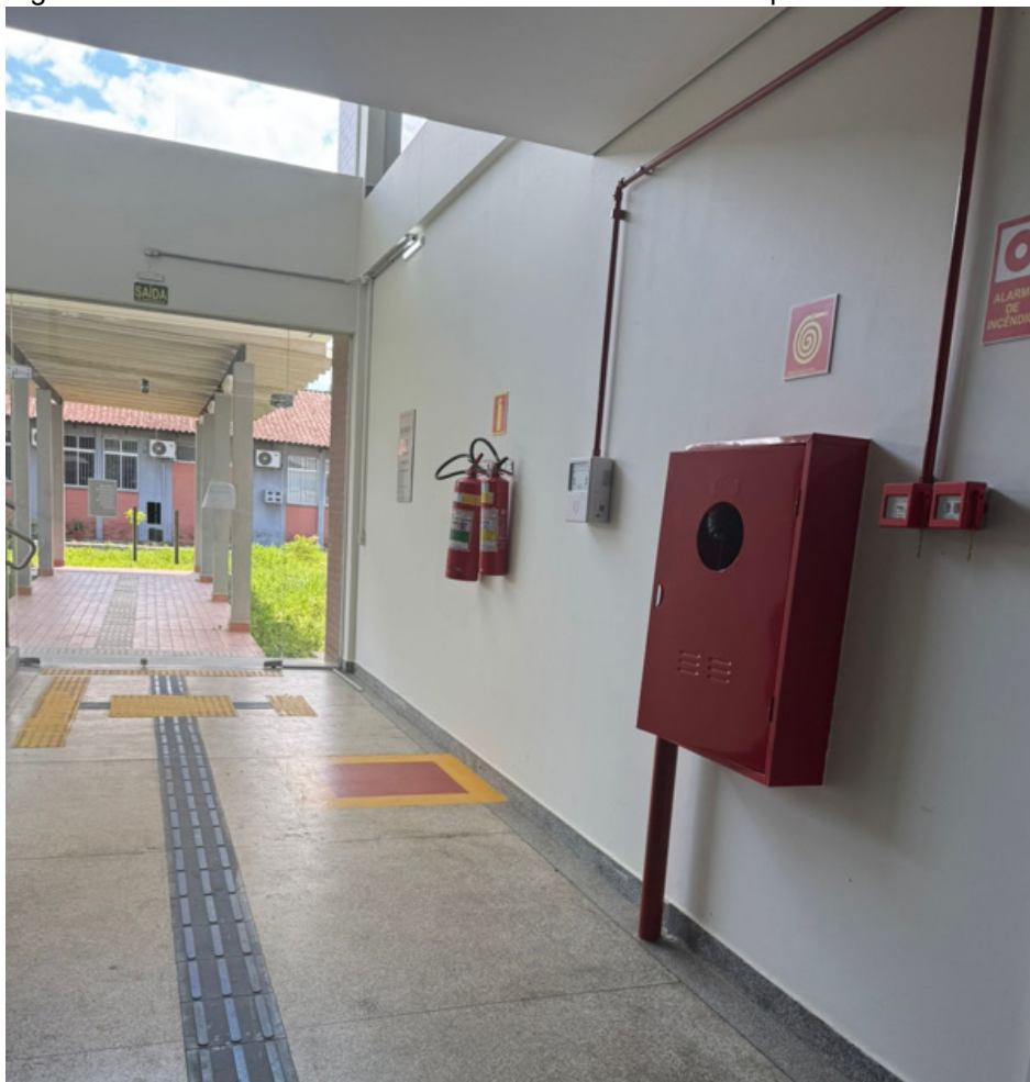
Figura 110 - Corredor de Acesso do Bloco do CFCH - Campus Sede.
