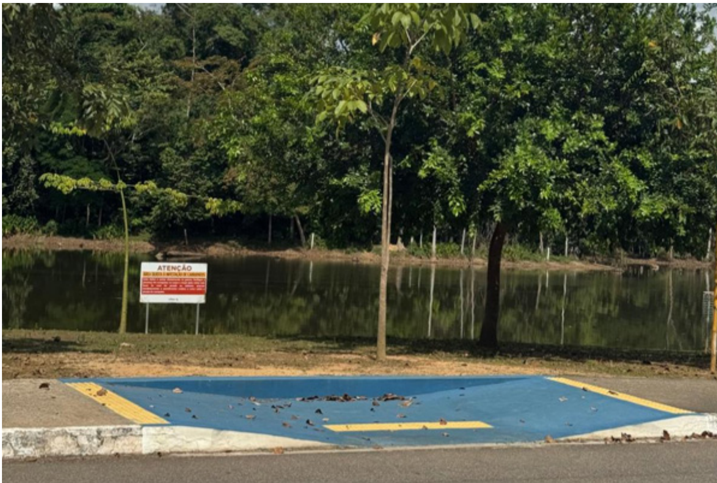
Figura 142 - Rampa de acesso do Anel Viário.
