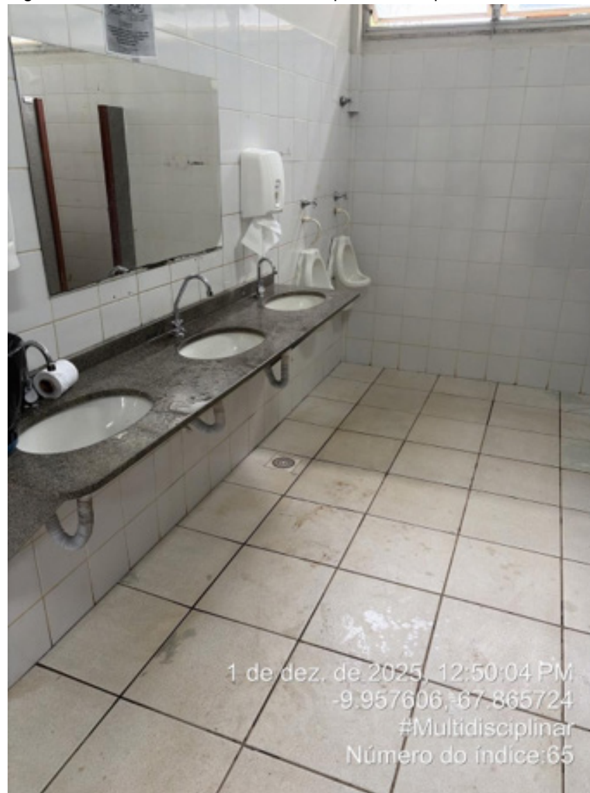
Figura 68 - Sanitário do Bloco Multidisciplinar - Campus Sede.
