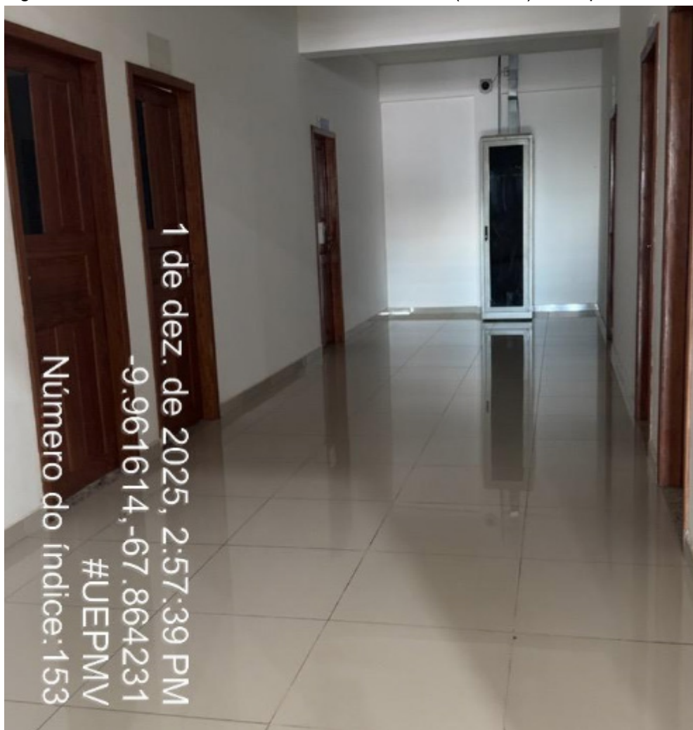
Figura 46 - Corredor do Bloco Dr. Mário Alves Ribeiro (UEPMV) - Campus Sede.
