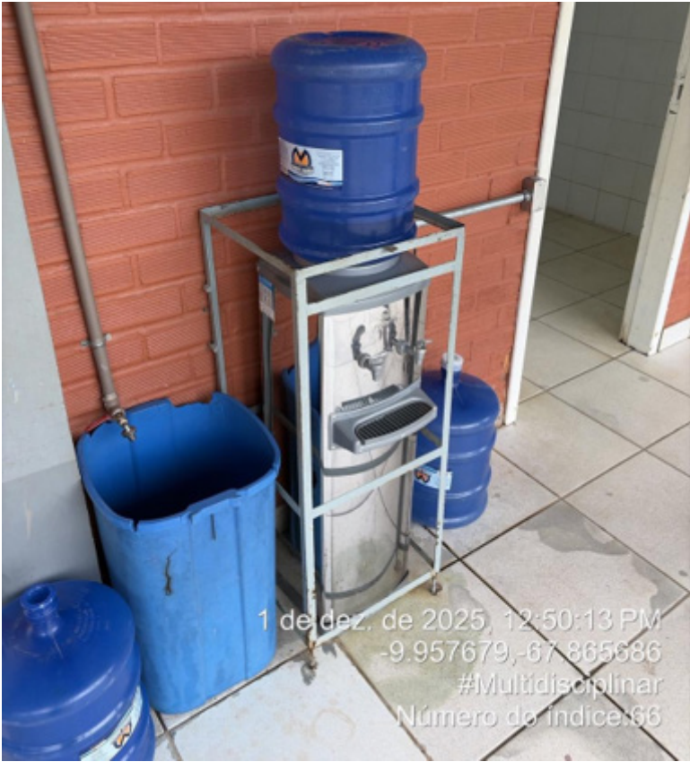
Figura 82 - Bebedouro do Bloco Multidisciplinar - Campus Sede.
