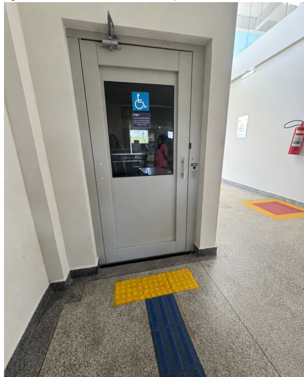
Figura 95 - Elevador do Bloco do CFCH - Campus Sede.
