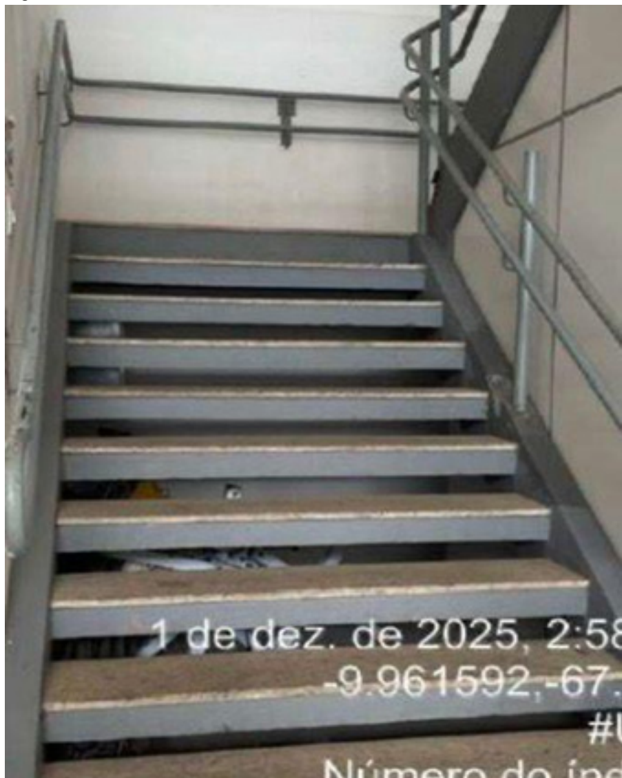
Figura 33 - Escada do Bloco de Medicina Veterinária.
