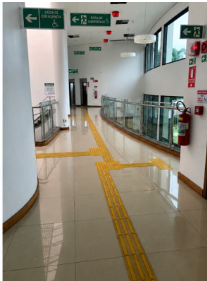
Em Conformidade com a Norma
