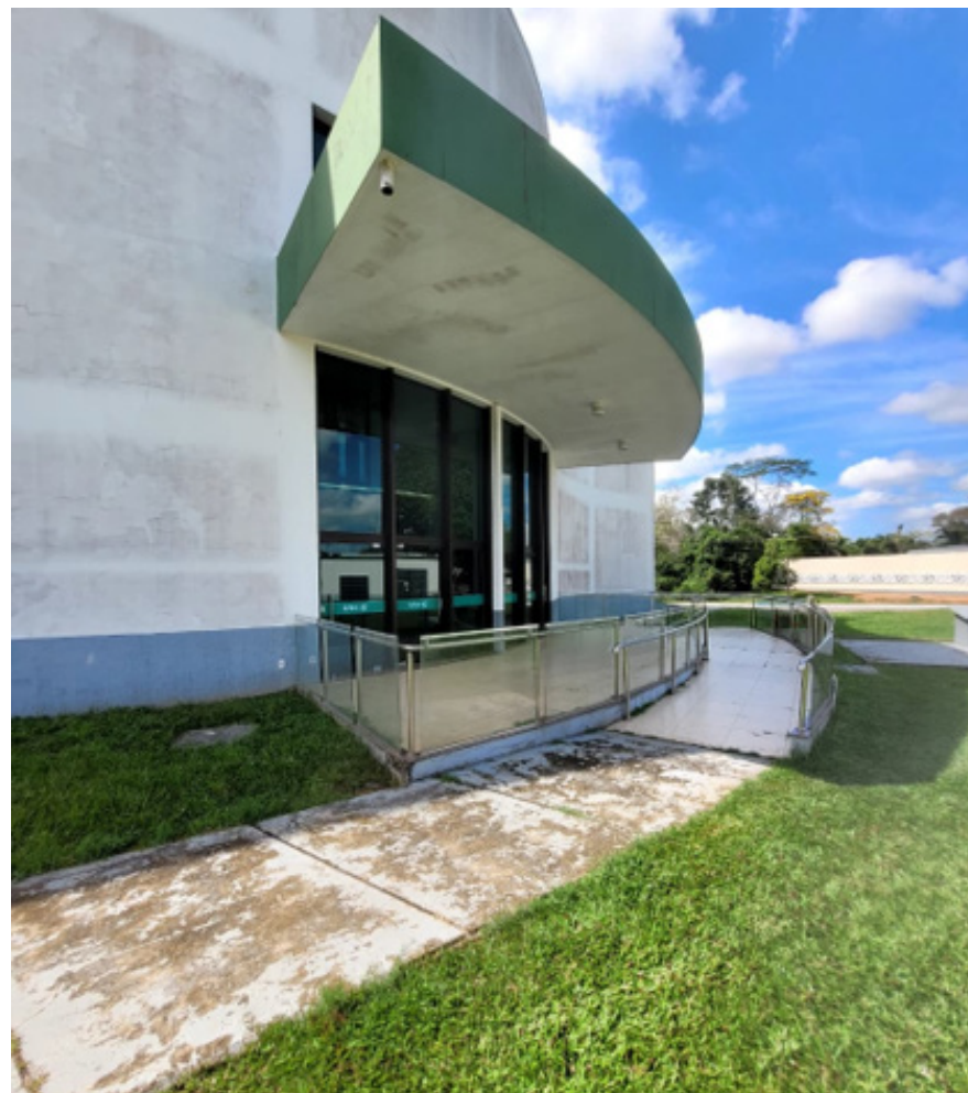
Figura 21 - Rampa externa do Teatro Universitário - Campus Sede.
