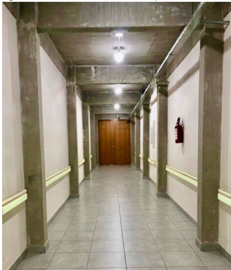
Figura 52 - Corredor do Bloco CELA - Campus Sede.
