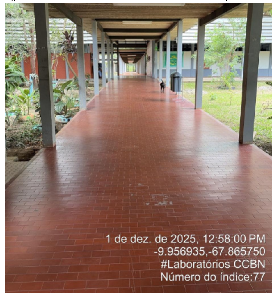
Figura 86 - Passarela do Bloco de Laboratórios do CCBN - Campus Sede.
