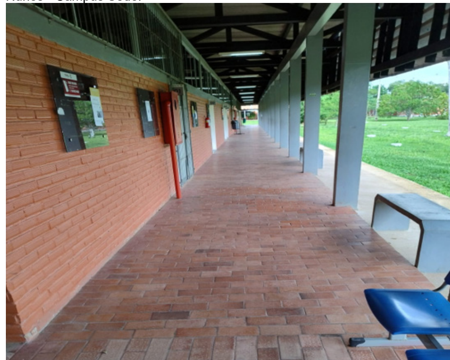
Figura 103 - Corredor de sala de aula do Bloco Jersey Nazareno de Brito Nunes - Campus Sede.
