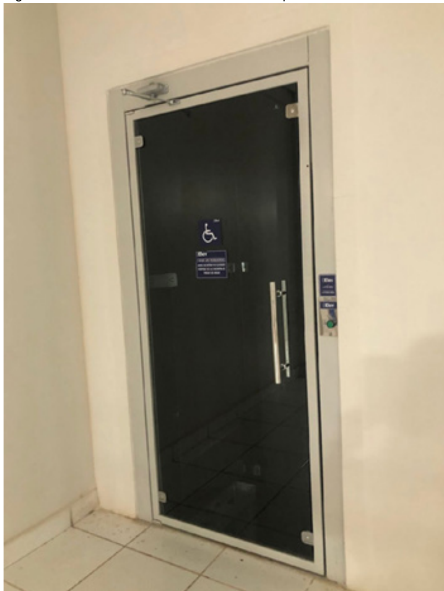
Figura 96 - Elevador do Bloco do Nurca - Campus Sede.
