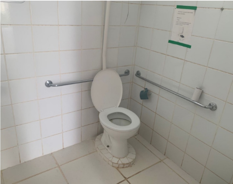
Figura 66 - Sanitário para pessoa com deficiência - Núcleo de Sena Madureira.
