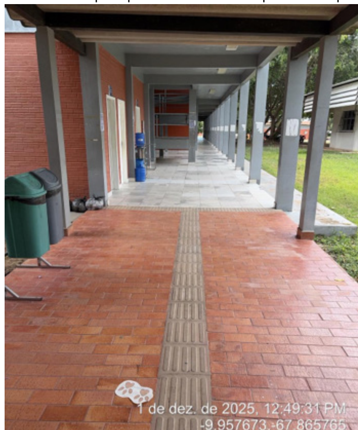
Figura 91 - Corredor principal do Bloco Multidisciplinar - Campus Sede.
